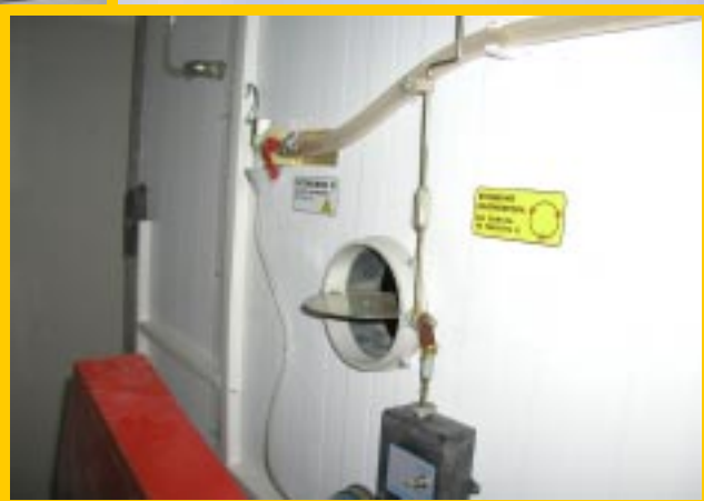
Механизм плавного управления воздушной заслонкой
